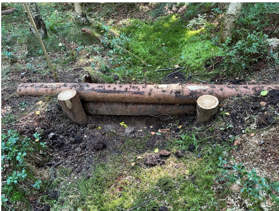
Konstrukce drobných hradítek
